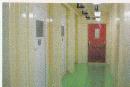
Módulo habitacional instalado na plataforma
